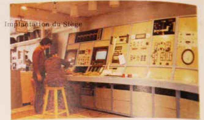
Salle de commande de la soufflerie F1.
